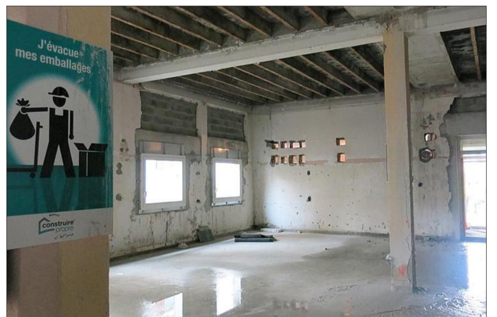
Le nouveau bâtiment comprend un rez-de-chaussée avec des bureaux, 90m 2 de cuisine, l'accueil et deux chambres pour les personnes à mobilité réduite.
