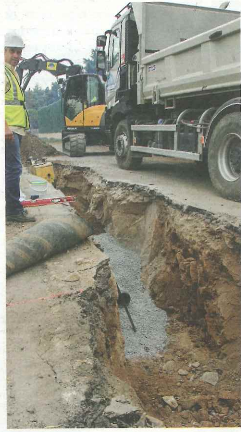
La valorisation des déchets de chantier se développe, comme ici, à Soucieu-en-Jarest, avec l'utilisation de graves chaulées
